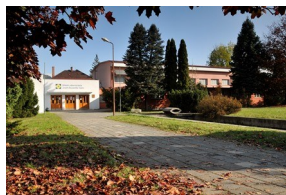
Hlavní budova školy
